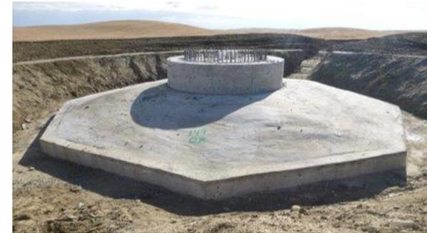
Une quantité d'environ 400 à 800 mètres cube de béton est nécessaire pour la fondation de chaque éolienne.
