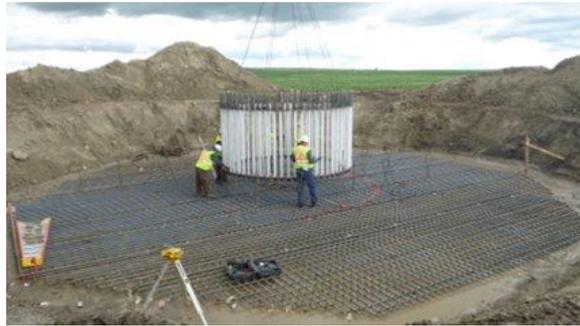
La pose de l'acier d'armature comprend entre 50 et 70 tonnes de barres d'armature.
