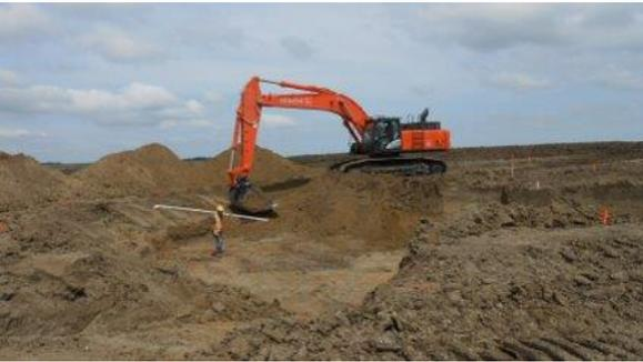
L'excavation des fondations est d'un diamètre d'environ 25 mètres.
